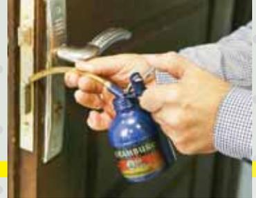
**فوت کوزه‌گری ۱:** برای روان کردن قفل‌ها از مقدار خیلی کمی پارافین مایع استفاده کنید. استفاده از روغن خوراکی باعث آسیب‌دیدگی اجزای داخلی قفل می‌شود. برای روان کردن لولاهای در هم بهتر است از مقدار کمی روغن بی‌رنگ، مثل روغن چرخ خیاطی، استفاده کنید؛ چون هم رقیق‌تر است و ماندگاری بیشتری دارد و هم در و چارچوب را کثیف و زرد نمی‌کند.
