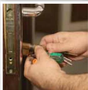
اگر سیلندر درست جا افتاده باشد، زبانه آن خیلی راحت باید بیرون بیاید و به عقب برود (در حالت قفل و باز قرار گیرد). سیلندرهایی قفل معمولاً سه مرحله ای هستند: دو مرحله قفل و یک مرحله باز. اگر زبانه درگیر بود و به راحتی در حالت قفل (دو
